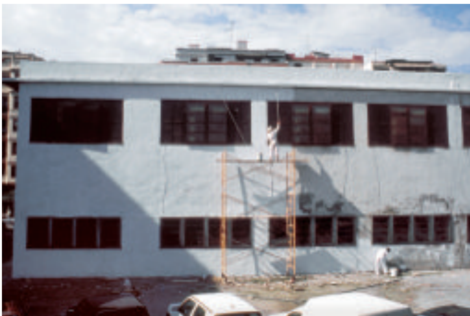
Restauration der Markthalle von Gros wenige Tage vor dem Abbruch, 1995, San Sebastián
